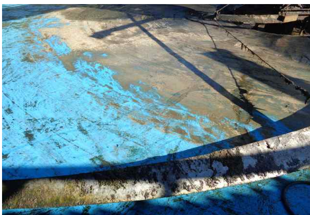
2지 내부 바닥 배수후 외관조사 ⇒ 상태 양호
