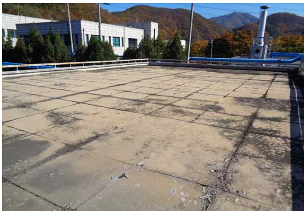
유입펌프장 옥상층 전경
