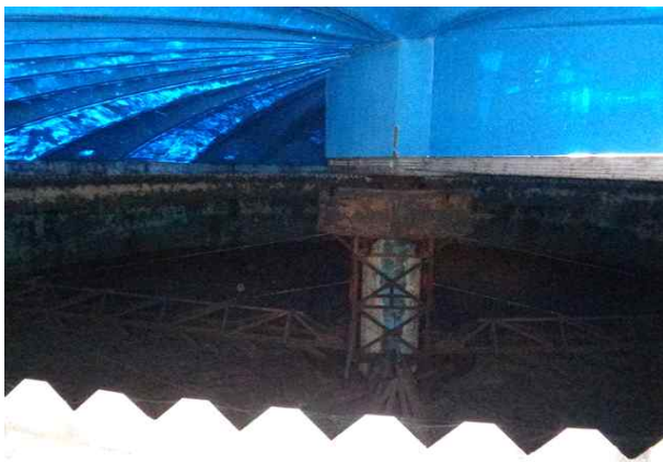
우수침전지 내부 전경
