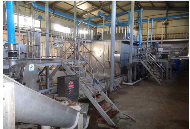
침사지 내부 전경
