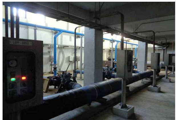
유입펌프장 내부 지하층 전경
