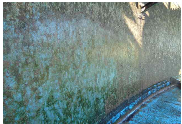
2지 내부 벽체 배수후 외관조사 ⇒ 상태 양호
