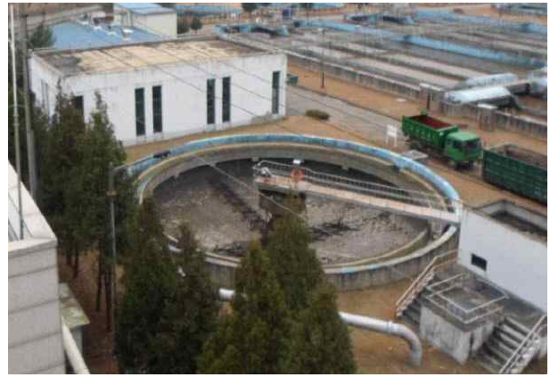
전회 전경 우수침전지 FRP 지붕 증축전
