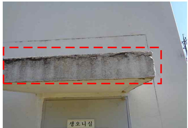
우수침전지 분배조 외부 박리 및 박락 (A=1.0m×0.2m)
